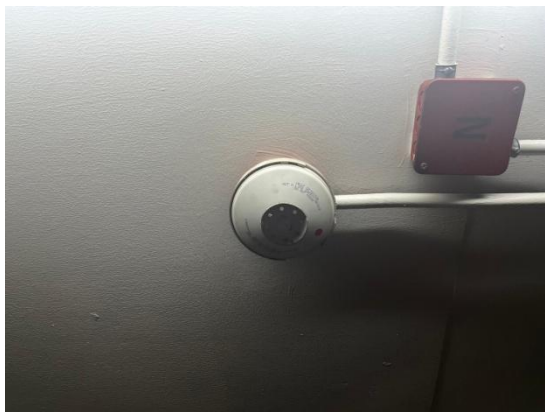
รูปที่ 2-39 เครื่องตรวจจับความร้อน
